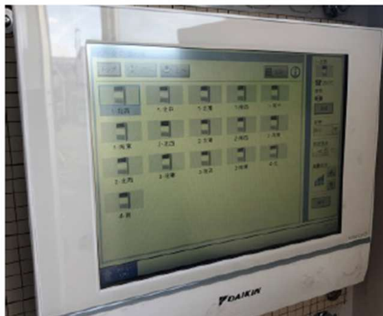
iTM(インテリジェントタッチマネージャー)にて運転状態を確認
